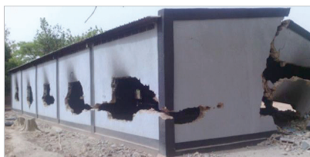
Это здание церкви в Лоропени практически полностью разрушено
